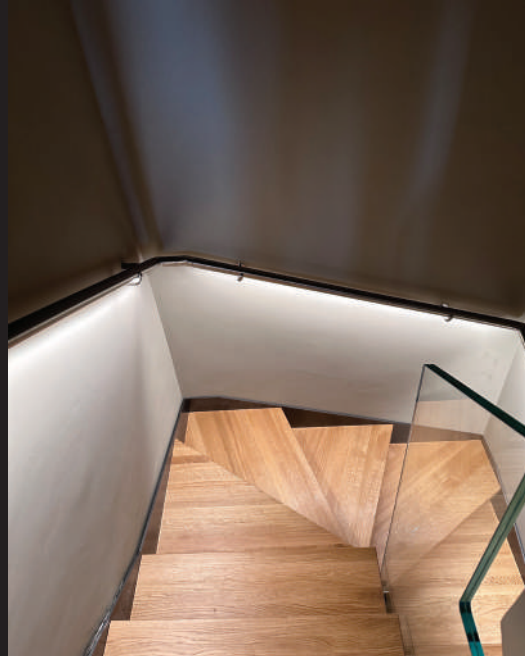
Abitazione Privata Ooi - Corrimano Scala Interna
