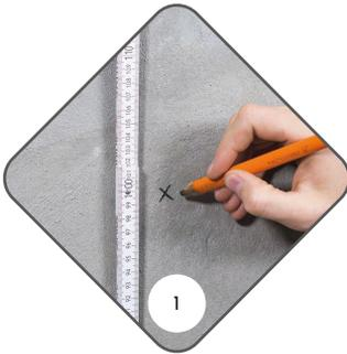
1. Such dir einen geeigneten Platz an der Wand. Überprüfe, ob dein Bike links und rechts genug Platz zu benachbarten Wänden und Möbeln hat. Als Erstes werden die beiden Reifen-Halter montiert. Markiere die Stelle, an der später dein Vorderrad hängen soll.
