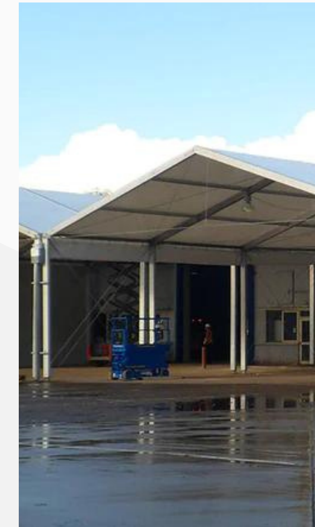
BUDOWA NAMIOTÓW I BRONI
