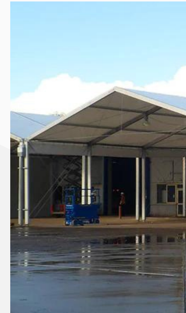
BAUZELTE UND - UNTERKÜNFTE
