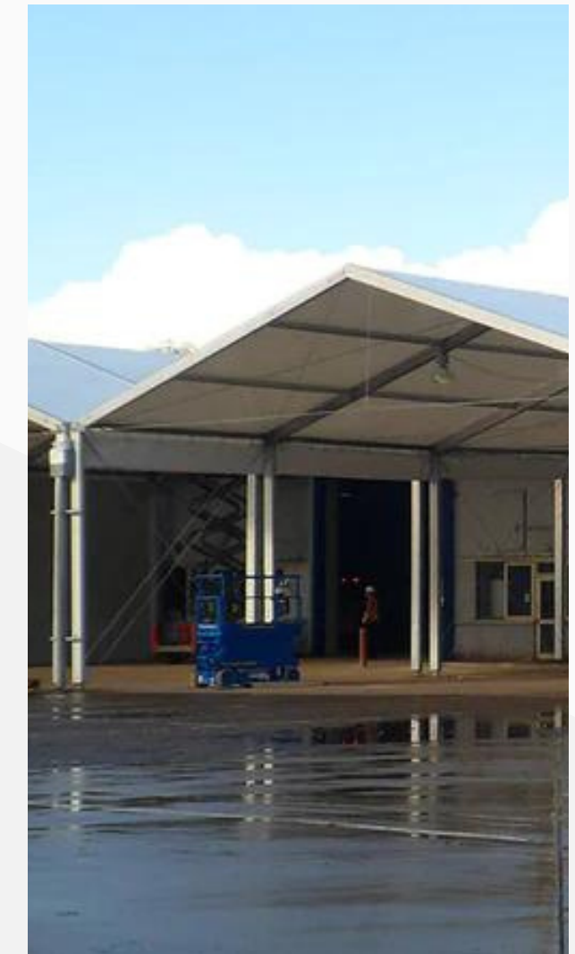
BAUZELTE UND - UNTERKÜNFTE
