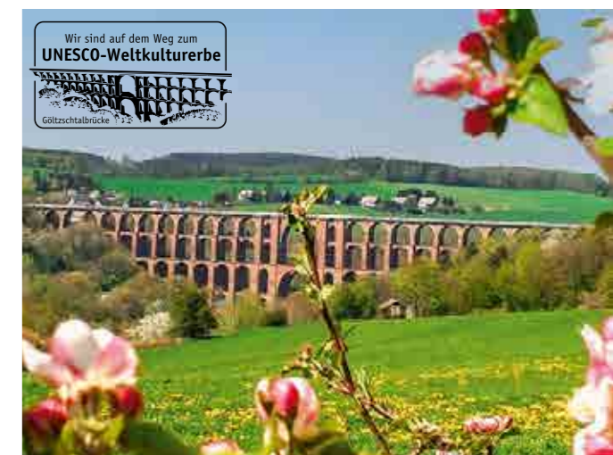
▲ Blick auf die Göltzschtalbrücke
