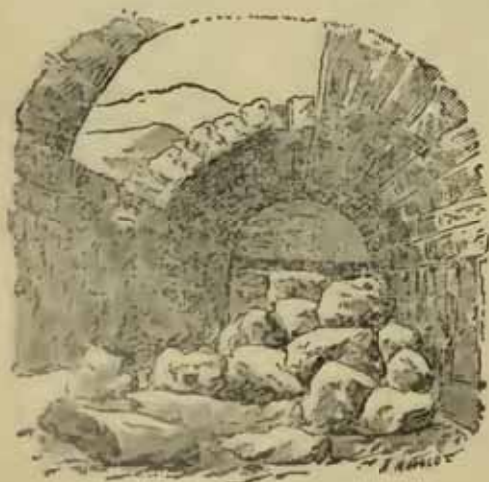
Le puits de Jacob. (État actuel.)
