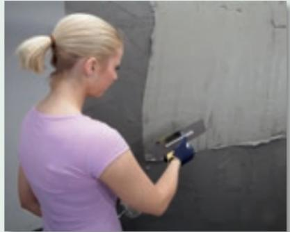
Die frisch aufgetragene Schicht stramm abziehen, bis der erste Farbton anfängt durchzuscheinen. Je strammer abgezogen wird, desto mehr scheint von dem ersten Farbton durch.
