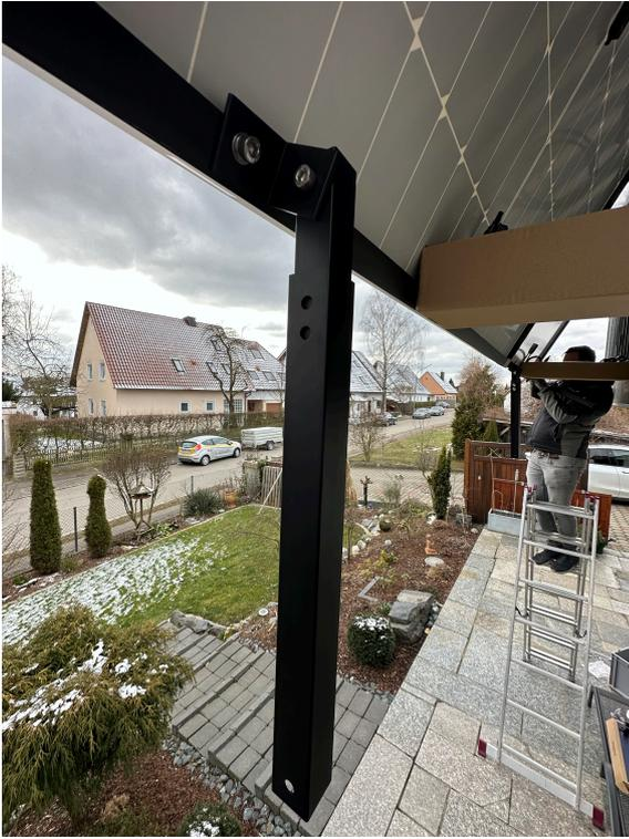
Schrauben Sie die Füße und die Teleskopstangen (4x) auseinander und montieren alle 4 Teleskopstangen wie auf dem Bild mit den 4 Schrauben 4x M8x25mm (Modul - Winkel) an das Modul.
