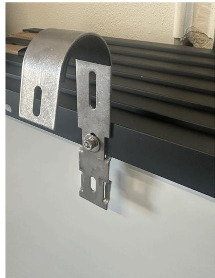
Bitte beachten: Innen ist die Sperrzahnmutter. TIPP: Den Haken gleich etwas „einbiegen“ damit er später besser um den Handlauf passt.
