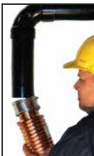
Retirez les bandes de métal et les attaches des raccords rigides et placez-les sur le ThermoDrain. Enroulez les raccords sur eux-mêmes et placez-les en position alignée avec la partie supérieure découpée du drain. Enroulez de nouveau le raccordement sur le drain, remplacez les parties métalliques et sécurisez. Sécurisez également les raccords inférieurs.
