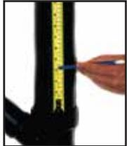
À partir du bas de la section verticale de votre drain d'évacuation, mesurez 3 po et faites une marque. Mesurez ensuite jusqu'au haut et ajoutez ½ po pour faire votre marque supérieure sur le drain. (Il est fortement recommandé de laisser autant d'espace que possible en haut de l'appareil sur votre drain afin de permettre la formation d'une pellicule.)
