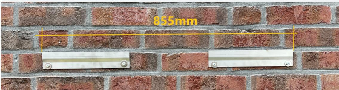
Befestige die Wandprofile mit den Dübelschrauben 6x60. Die mitgelieferten Dübel sind zulässig für Beton, Vollziegel, Kalksandvollstein, Hochlochziegel, Kalksandlochstein und Porenbeton.
