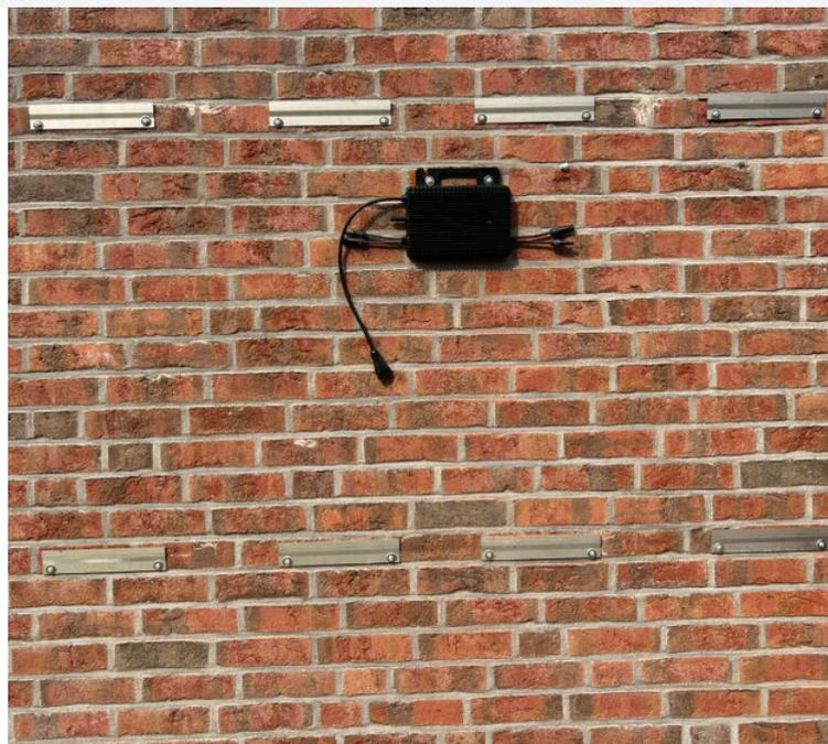
Führe das Stromkabel seitlich, nach unten oder rückseitig durch die Wand zur nächsten Steckdose.
