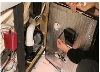
**ÉTAPE 3** - Débrancher le câblage du boîtier
