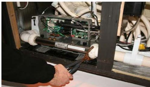
Débranchez l'entrée et la sortie des unions au boîtier de contrôle
