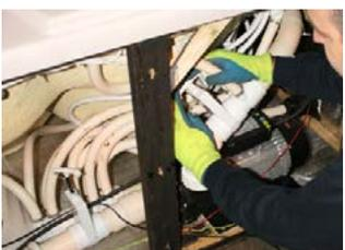
**ÉTAPE 4** - Fermez les deux robinet guillotines pour isoler l'eau
