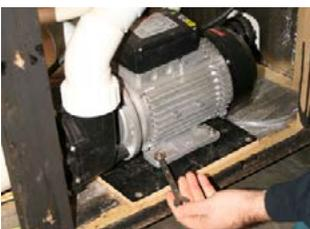
**ÉTAPE 8** - Enlevez les 4 écrous de la base de la pompe en utilisant une clé "(13mm) 1/2"
