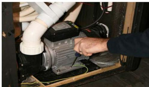
Retirez les moteurs, pompes, l'électronique, et la soufflerie et les entreposez dans un endroit chaud et sec
