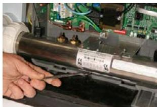
**ÉTAPE 7** - Dévissez les deux écrous de verrouillage de supports sur le tube à l'aide de la clé 3/8
