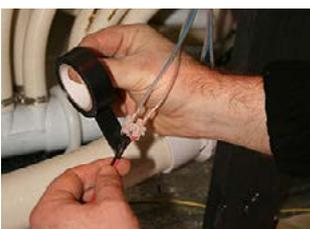
**ÉTAPE 10** - Isolez les connections avec du ruban électrique.
