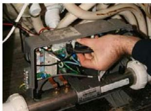
**ÉTAPE 6** - Retirez la connexion du fil de la pompe. Et débranchez la connexion de la pompe de la carte électronique (Assurez-vous que toutes les attaches de câble sont retirées de la plomberie)
