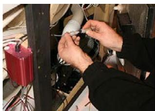
**ÉTAPE 2** - Dévisser l'écrou puis débrancher la connexion de l'amplificateur
