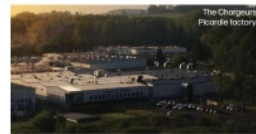
The Chargeurs PCC factory
