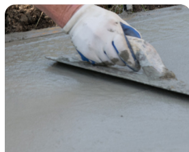
Dalles de béton
