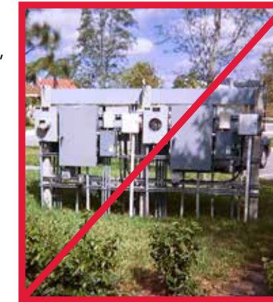
Puntal y tablero
