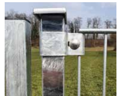
Zaunanschluss mit Schellen
