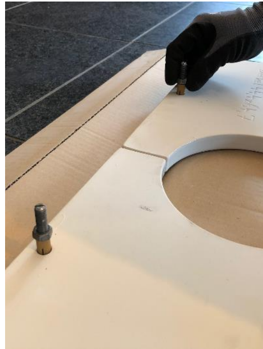
18. Vor Montage der Keramik-Topplatte müssen zwei Gewindestifte (M8 x 50) eingeschraubt werden. Des weiteren drehen Sie bitte jeweils eine Mutter (M8) auf die Stifte.
