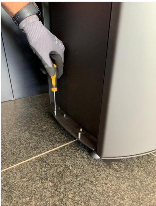
3. Drehen Sie nun zwei der Gewindestifte (M5 x 20) soweit in den unteren Keramikhalter ein, dass diese mit der Unterseite bündig abschließen.
