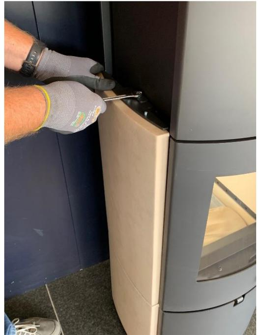
10. Wiederholen Sie die Schritte 7 bis 9 beim Anbringen des mittleren Keramikelementes. Überprüfen Sie vorsichtig, ob sich die Tür vollständig öffnen läßt – falls nicht, muss die Position der Keramik entsprechend korrigiert werden.
