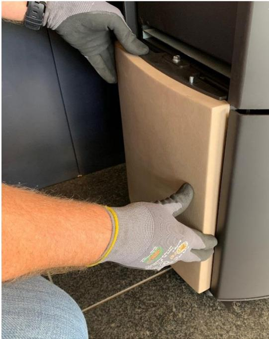
9. Richten Sie die Keramik so aus, dass ein Spaltmaß von ca. 3-5 mm entsteht. Ziehen Sie nun sowohl die Schrauben des unteren als auch des oberen Keramikhalters fest.
