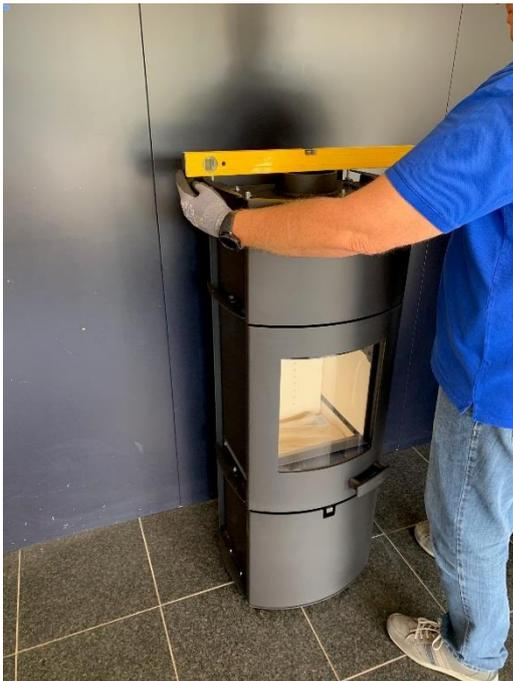
1. Platzieren Sie den Ofen vor der Montage der Keramik-Anbauteile an seinem zukünftigen Aufstellort. Richten Sie den Ofen mit Hilfe einer Wasserwaage aus.
