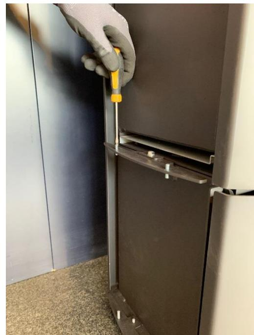
4. In die beiden mittleren Keramikhalter drehen Sie bitte vier der längeren Gewindestifte (M5 x 20) ein, sodass diese zur Hälfte oberhalb und zur anderen Hälfte unterhalb des Halters zu sehen sind.
