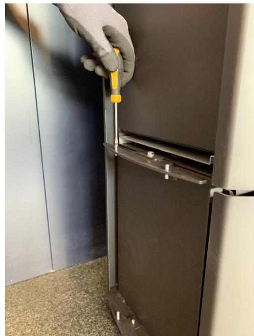
7. Veuillez visser quatre des tiges filetées plus longues (M5 x 20) dans le support en céramique du milieu, de façon à ce que ces dernières soient visibles à moitié au-dessus et à moitié en-dessous du support.
