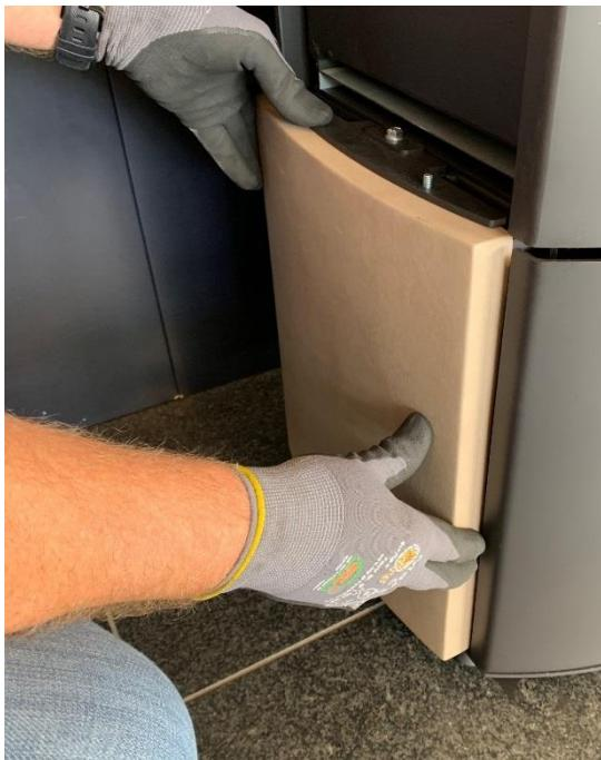
9. Orientez la céramique de façon à ce qu'il y ait un entrefer d'env. 3-5 mm. Serrez maintenant autant les vis du support en céramique inférieur que du support en céramique supérieur.
