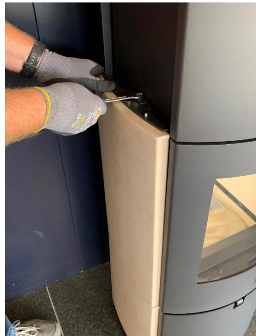
10. Wiederholen Sie die Schritte 7 bis 9 beim Anbringen des mittleren Keramikelementes. Überprüfen Sie vorsichtig, ob sich die Tür vollständig öffnen lässt – falls nicht, muss die Position der Keramik entsprechend korrigiert werden.
