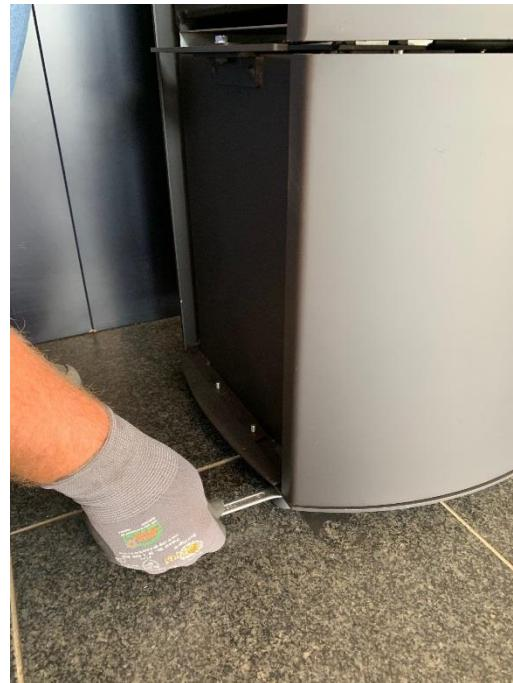
4. Gebruik de hoogteverstellers in de bodem van de kachel voor het uitlijnen. Deze kunnen worden aangepast met een 13 moersleutel.
