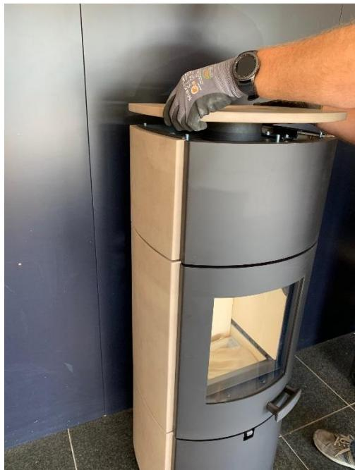
13. Plaats nu voorzichtig de keramische bovenplaat op de kachel. De plaat kan worden uitgelijnd door de stelschroeven met behulp van een sleufschroevendraaier af te stellen.
