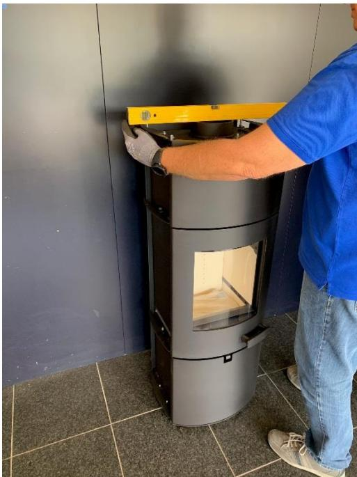
1. Avant le montage des pièces de fixation en céramique, placez le poêle sur le lieu où il doit être installé. Ajustez-le à l'aide d'un niveau à bulle.
