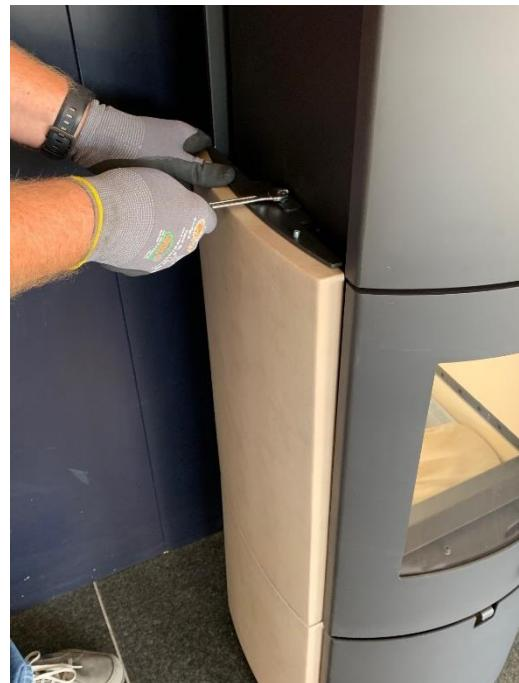
12. Herhaal stap 7 tot 9 bij het bevestigen van het middelste keramische element. Controleer zorgvuldig of de deur volledig kan worden geopend - zo niet, dan moet de positie van het keramiek overeenkomstig worden aangepast.
