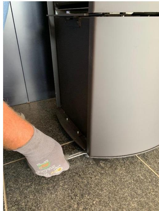
2. Nutzen Sie zur Ausrichtung die Höhenversteller im Fuß des Ofens. Diese lassen sich mit einem 13 Maulschlüssel einstellen.
