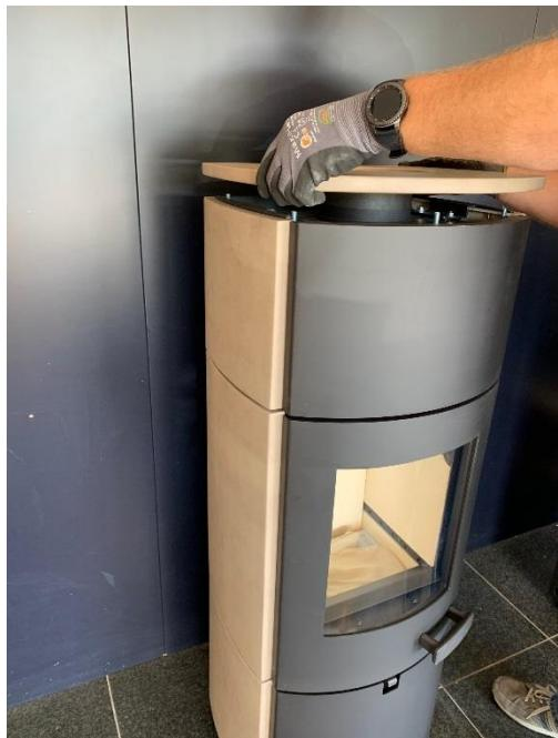
13. Maintenant, placez avec précaution la plaque supérieure en céramique sur le four. En ajustant le filetage La plaque peut être alignée à l'aide d'un tournevis à fente.
