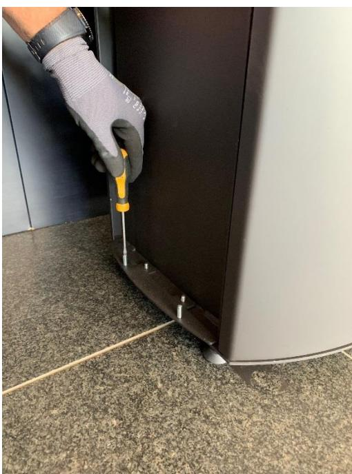
3. Schroef nu twee van de stelschroeven (M5 x 20) in de onderste keramische houder tot ze gelijk zijn met de onderkant.
