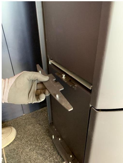
6. Lösen Sie nun die Verschraubung des zweiten Halters und legen Sie diesen zur Seite. Lösen Sie die zwei Befestigungsschrauben des unteren Halters (unterhalb des Ofens) nur geringfügig.
