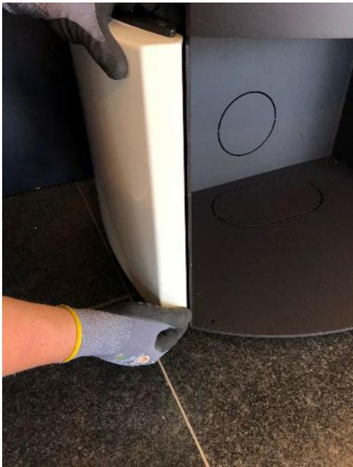
11. Richten Sie die Keramik so aus, dass zum Holzfach ein Spaltmaß von ca. 3-5 mm entsteht. Ziehen Sie nun sowohl die Schrauben des unteren als auch des oberen Keramikhalters fest.
