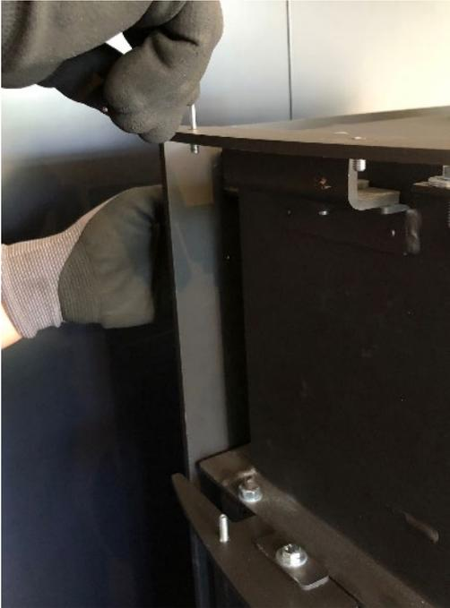
5. Drehen Sie nun zwei der kürzeren Gewindestifte (M5 x 12) soweit in den oberen Keramikhalter ein, dass diese mit der Oberseite bündig abschließen
