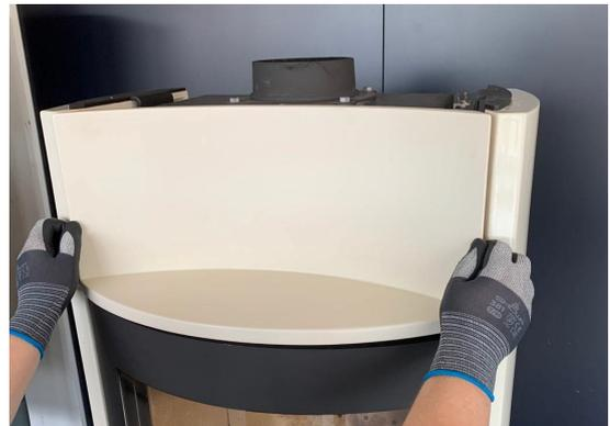
20. Setzen Sie das Teefach auf und richten Sie es aus. Das Teefach wird nicht weiter befestigt!
