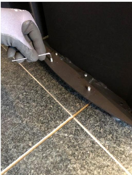
3. Drehen Sie nun zwei der kürzeren Gewindestifte (M5 x 12) soweit in den unteren Keramikhalter ein, dass diese mit der Unterseite bündig abschließen.
