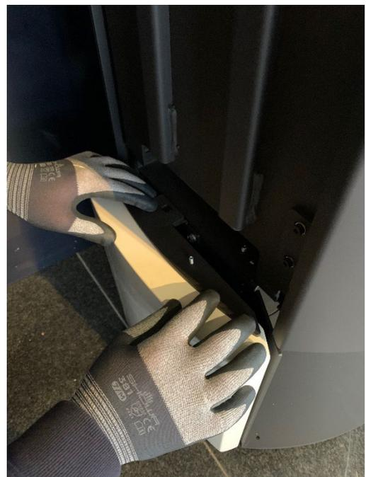
8. Führen Sie die Gewindestiftenden des zweiten Halters in die Keramik ein und bringen Sie die Keramik in Position. Achten Sie darauf, dass zwischen Metall und Keramik kein Zwischenraum verbleibt.
