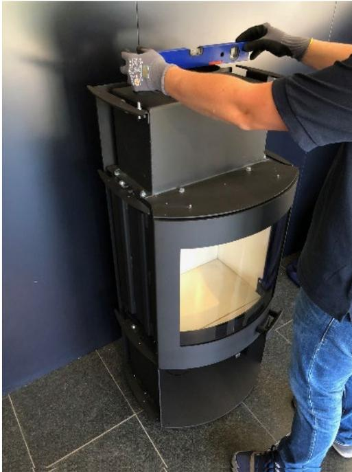
1. Platzieren Sie den Ofen vor der Montage der Keramik-Anbauteile an seinem zukünftigen Aufstellort. Richten Sie den Ofen mit Hilfe einer Wasserwaage aus. Entfernen Sie vorerst die Rückwand des Ofens.
