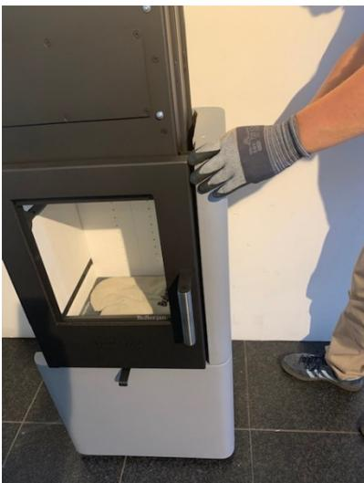
12. Setzen Sie die zweite Kachel auf die Gewindestangenenden und drücken Sie die Kachel an den Ofenkörper.
