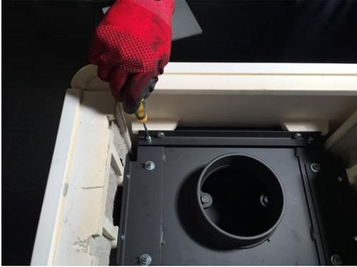
22. Über das Herein- und Herausdrehen der Gewindestifte in der Halteleiste lässt sich die Frontplatte in der Höhe ausrichten, sodass diese mit den Seitenteilen abschließt.
