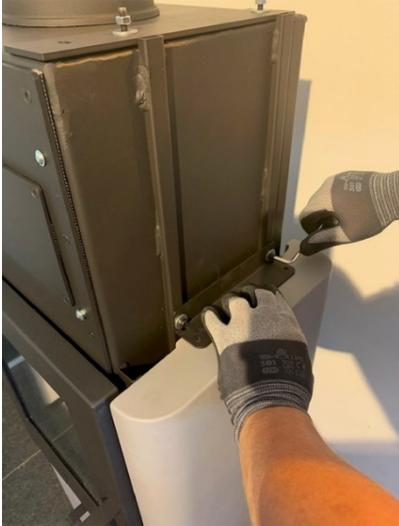
13. Fixer à nouveau la cornière en acier précédemment retirée au corps du poêle. L'angle doit reposer complètement et à plat sur la tuile du dessous.
