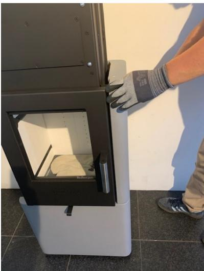
12. Placez la deuxième tuile sur les extrémités des tiges filetées et pressez la tuile contre le corps du poêle.
