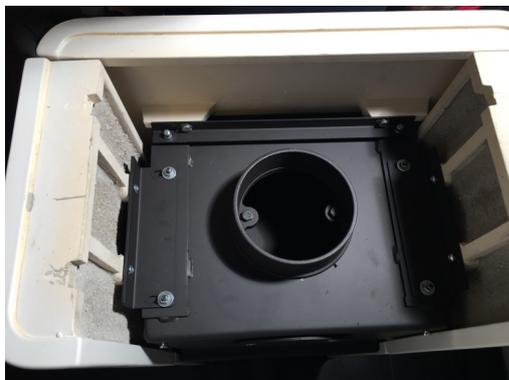
21. Accrochez maintenant avec précaution le panneau frontal avec les extrémités des tiges filetées dépassant vers le bas de la bande de retenue dans les trous prévus à cet effet.
