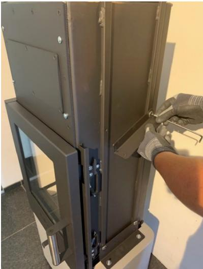
11. Verwijder de tweede stalen hoek alvorens de tweede zijtegel te bevestigen.
