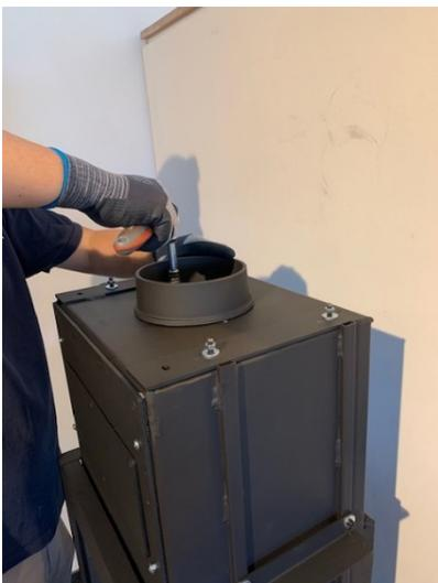
3. Montieren Sie den Abgastutzen mit Hilfe einer Knarre, 13er Nuss an der gewünschten Position (oben oder hinten).
