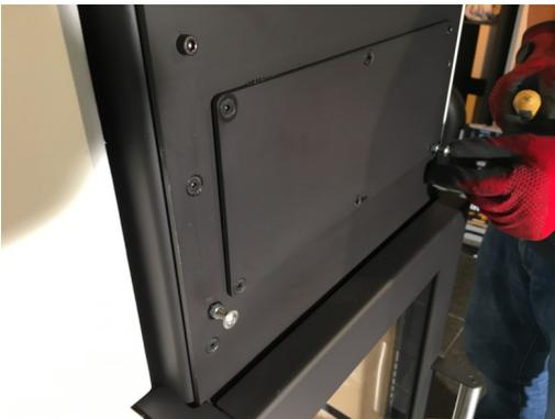
23. Si la plaque frontale doit encore être alignée verticalement, les vis d'écartement de la plaque frontale du poêle peuvent être vissées ou dévissées en conséquence. Lorsque la position correcte a été trouvée, sécurisez la position des vis en serrant les écrous.
