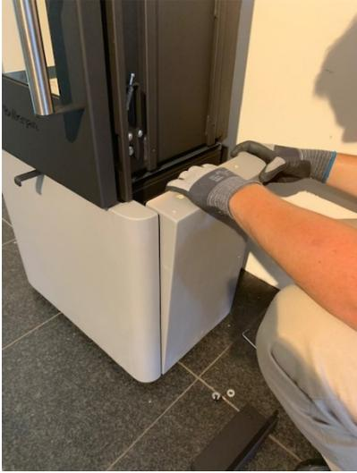
7. Placez maintenant la tuile latérale la plus basse sur les boulons de positionnement.
