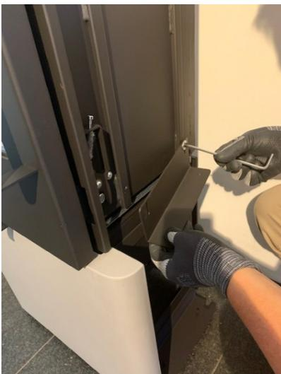
6. Om de eerste onderste zijtegel te installeren, verwijdert u de bevestigingsschroeven van de voormonteerde stalen hoek.
