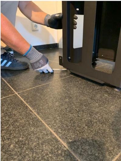
2. Gebruik de hoogteverstellers in de bodem van de kachel voor de uitlijning. Deze kunnen worden aangepast met een 13 mm steeksleutel.
