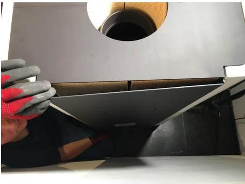
27. Hängen Sie nun die Rückwand ein und fixieren Sie diese mit den Schrauben (M5 x 10).
