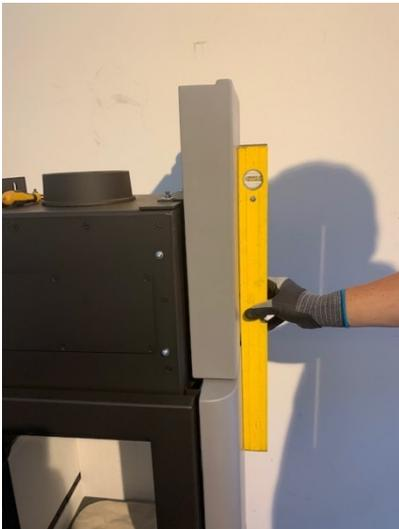
17. Überprüfen Sie mit einer Wasserwaage die Position der Kachel und richten Sie diese ggf. aus.
