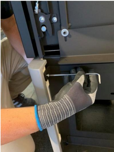
5. Fixez le carreau frontal le plus bas des deux côtés avec les vis (M6 x l6).
