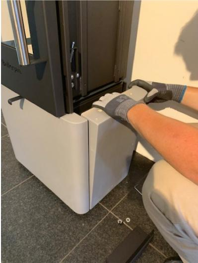
7. Setzen Sie nun die unterste Seitenkachel auf die Positionierbolzen.
