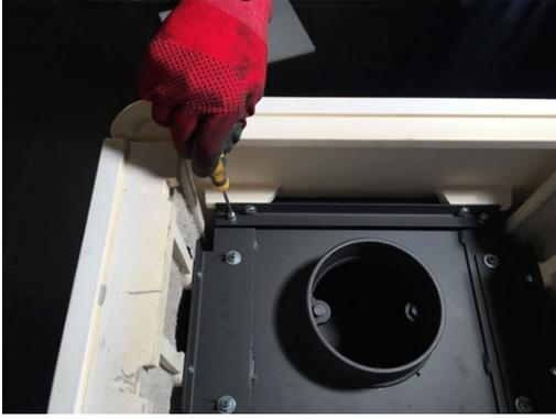
22. Door de stelschroeven in en uit de bevestigingsrail te schroeven, kan het frontpaneel in de hoogte worden uitgelijnd, zodat het gelijk ligt met de zijpanelen.
