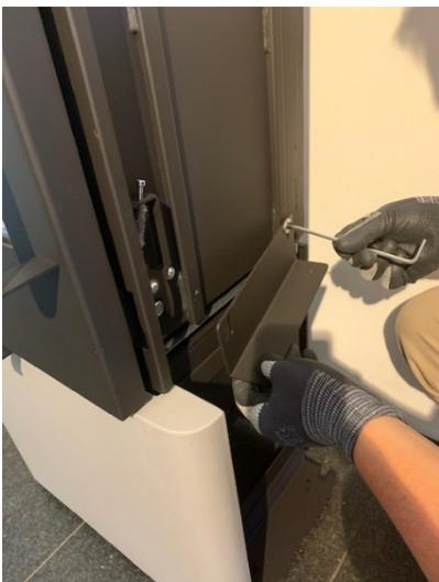
6. Zur Montage der ersten untersten Seitenkachel entfernen Sie die Befestigungsschrauben des vormontierten Stahlwinkels.
