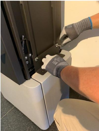
8. Plaats de tegel op zijn plaats en druk de hoek erboven op de tegel van bovenaf en schroef deze stevig terug op het kachellichaam. De hoek moet volledig en vlak op de onderstaande tegel rusten.
