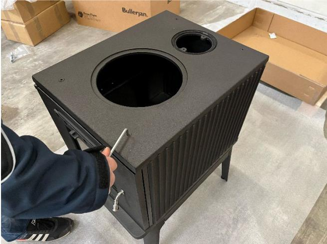
8. Lösen Sie bitte die vier Befestigungsschrauben des Ofenkörperdeckels.
