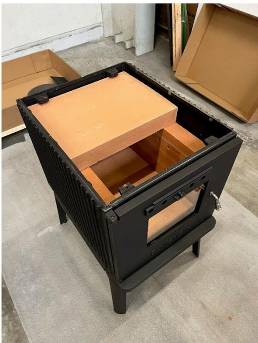
17. Legen Sie nun die größere der beiden Umlenkplatten quer auf die bereits eingesetzten Platten auf und schieben Sie diese an die Rückwand des Ofens.
