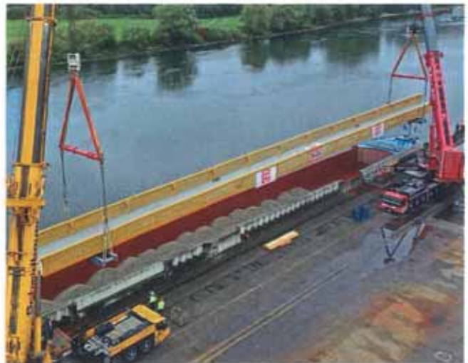
Fig. 32 | Appoggio del ponte ciclo-pedonale sulla chiatta. © ACME
