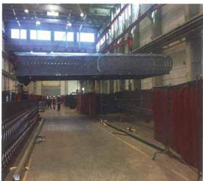
Fig. 26 | Costruzione della struttura di acciaio del ponte ciclo-pedonale in officina. © Max Streicher
