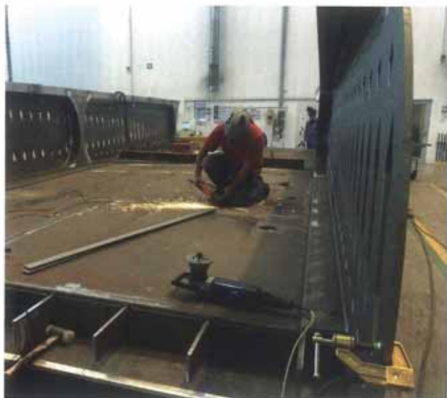
Fig. 23 | Costruzione della struttura di acciaio del ponte ciclo-pedonale in officina. © Max Streicher
