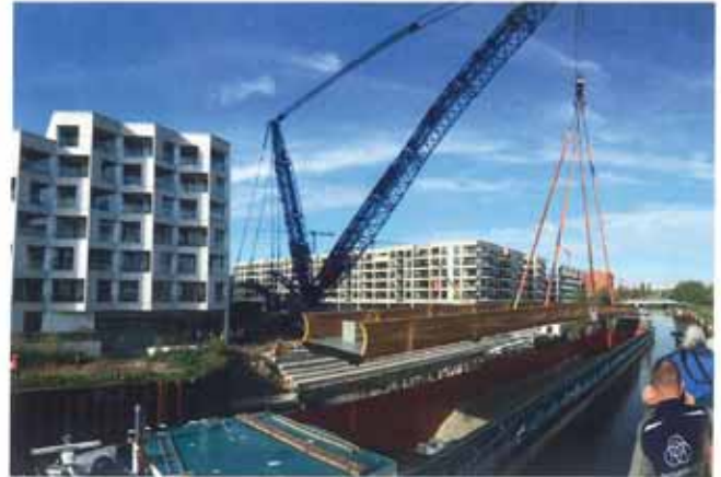
Fig. 34 | Fase di sollevamento del ponte dalla chiatta. © ACME
