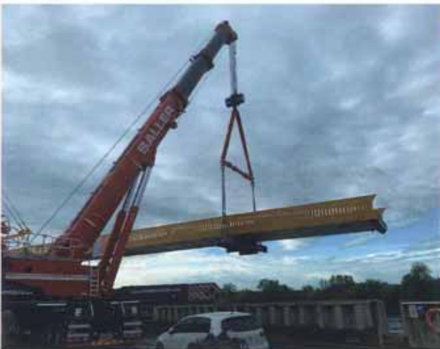
Fig. 31 | Sollevamento del ponte ciclo-pedonale. © ACME
