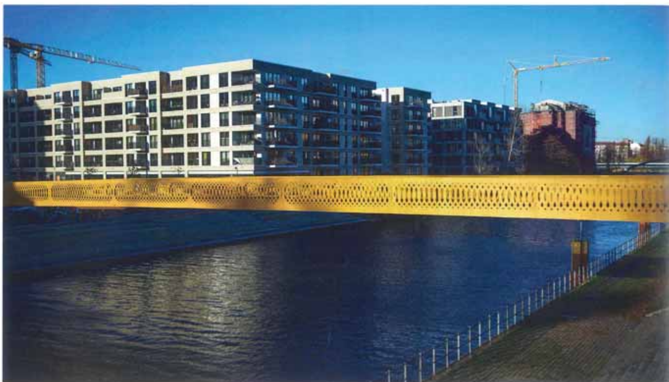
Fig. 11 | Vista del Golda Meir Steg dalla sponda est del canale. © Alex van Doorn
