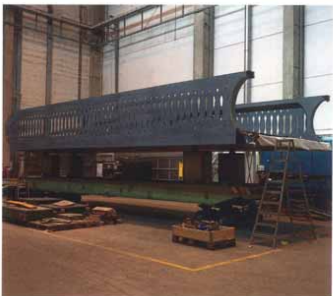
Fig. 25 | Costruzione della struttura di acciaio del ponte ciclo-pedonale in officina. © Max Streicher
