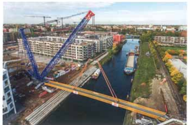
Fig. 36 | Fase appoggio del ponte sulle pile. © ACME
