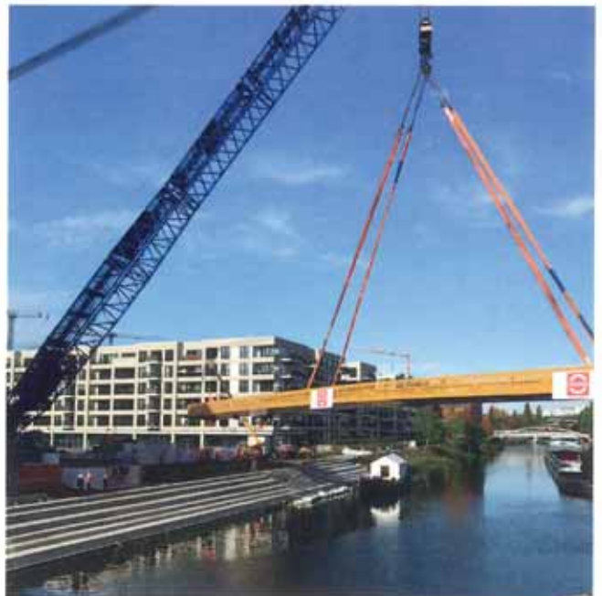
Fig. 35 | Fase di rotazione e allineamento del ponte agli appoggi. © ACME
