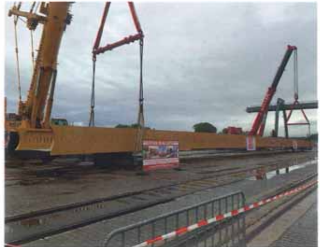
Fig. 30 | Sollevamento del ponte ciclo-pedonale. © ACME
