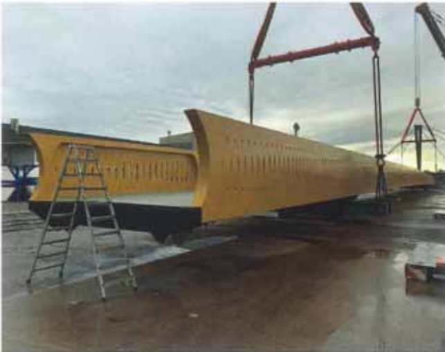
Fig. 29 | Trasporto del ponte ciclo-pedonale all'imbarco. © ACME
