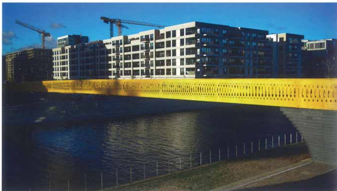
Fig. 1 | Vista del ponte ciclo-pedonale Golda Meir dalla sponda est del canale Berlino-Spandau. © Alex van Doorn
