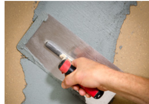
Edelputz mit der Edelstahl-Glättekelle auftragen
