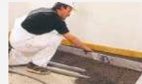
Liaporfitstreifen mit Waaglatte: in den Zwischenraum eingefülltes Liaporfit mit Waaglatte abziehen.
