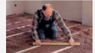
Liapor 4/8 bzw. Liapor 8/16 zwischen die Hilfskonstruktionen einfüllen und anschließend sauber abziehen.
