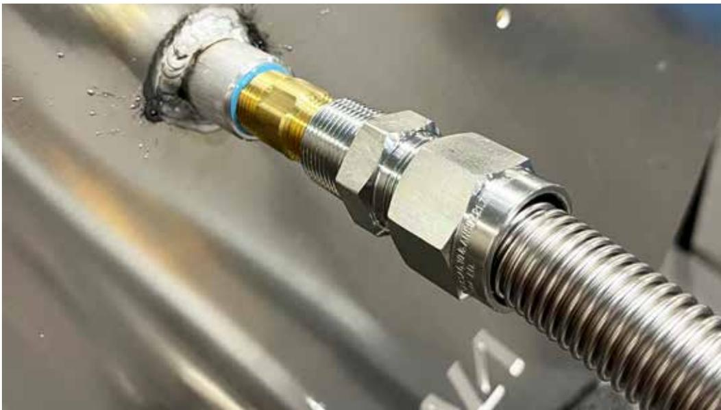
Foto 18: Conexión de la línea flexible
