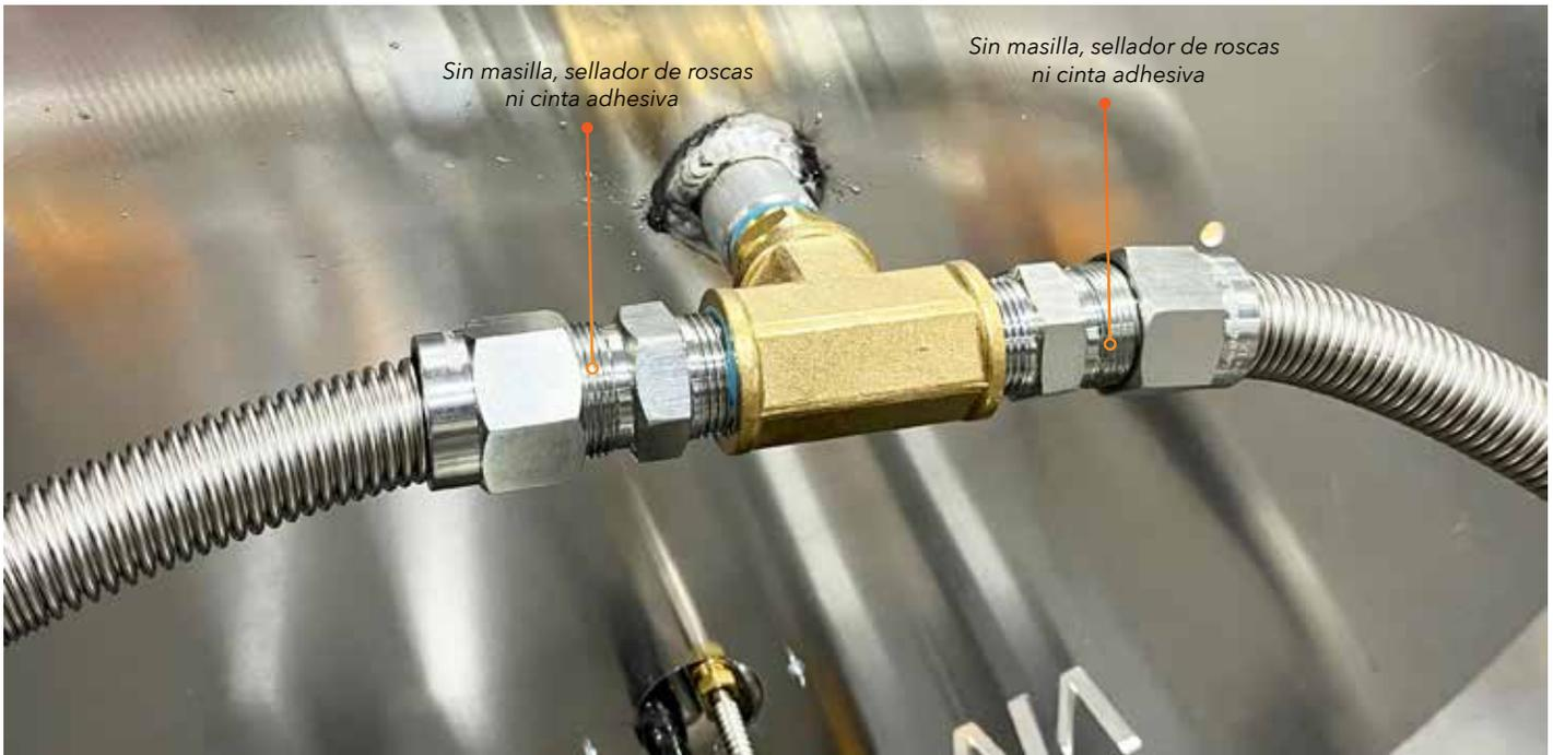
Foto 20: Conexión de las líneas flexibles
