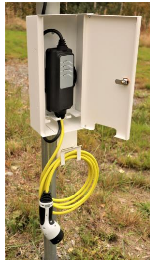
Aseta laturi kotelon sisälle tuen päälle, ohjaa latauskaapeli ulos oven alareunassa olevasta aukosta ja aseta kaapeli johdonpitimeen.
