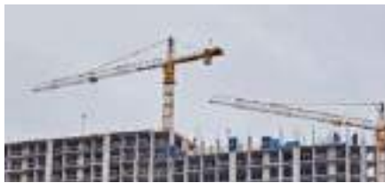
AUF DER BAUSTELLE
