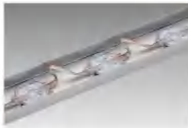
铝合金型材安装铝槽。 Aluminum alloy profile installation aluminum trough.
