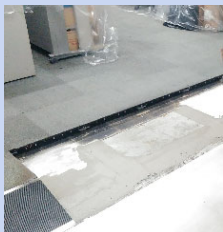
既存品を撤去
