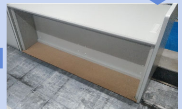
塞ぎ板設置完了
