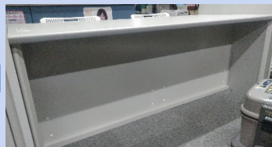
塞ぎ板部にカーペット設置
