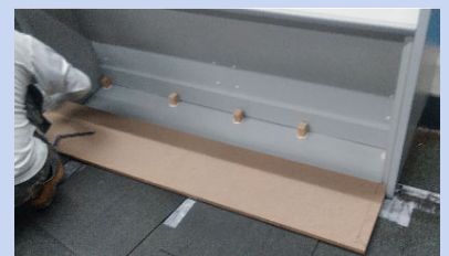
床段差解消のため塞ぎ板設置
