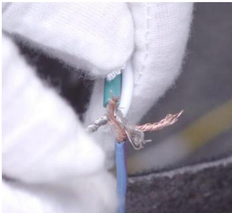
(iii) Conecte el extremo verde (30) al extremo del cable de la bomba de aceite cerca de la bomba de aceite.
