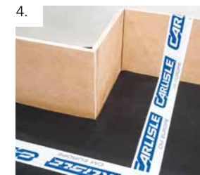
Grundierte Fläche (im Abstand von 5-10 mm) vor dem Auftrag von LIQUISEAL 1C SF erneut abkleben
