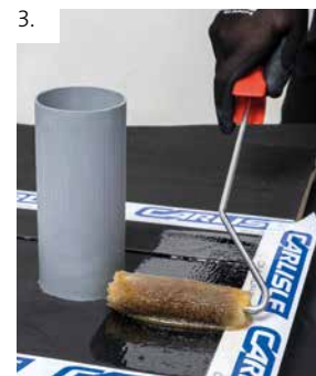
Fläche gemäß Grundierungsempfehlung behandeln. Hier LIQUISEAL Primer auf RESITRIX® bzw. HERTALAN® Abdichtungen auftragen, Klebeband abziehen. Grundierte Fläche (im Abstand von 5-10 mm) vor dem Auftrag von LIQUISEAL 1C SF erneut abkleben
