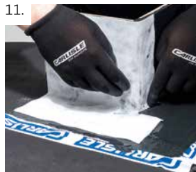
Kontrolle der Zuschnitte und Vorlagemengen, ggf. korrigieren
