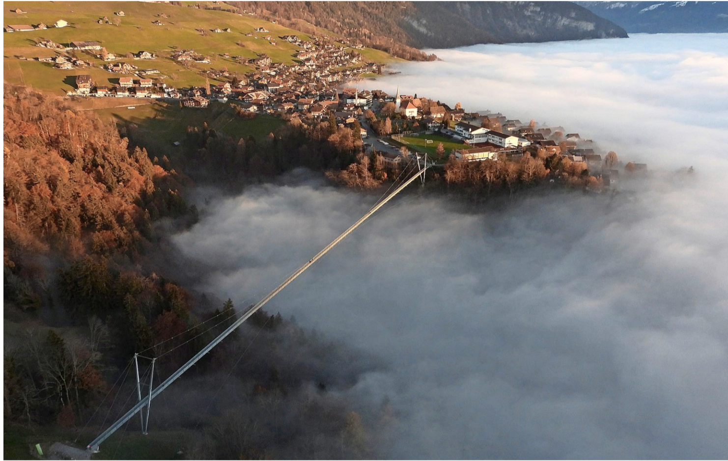
Neues Wahrzeichen: Die Hängebrücke verbindet die Dörfer Sigriswil und Aeschlen. Foto: Bruno Petroni
