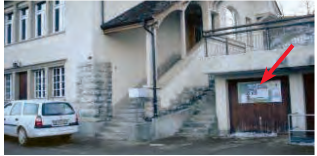
Aeschstrasse, an Garagentor beim Schulhaus Hondrich
