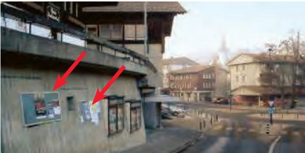
Seestrasse, Kronenplatz, an Stützmauer
