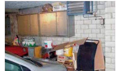
Schlechtes Beispiel einer Einstellhalle
