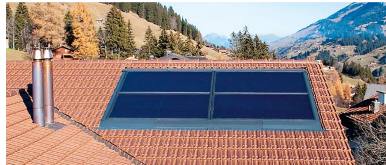
Der Einbau von Warmwasserkollektoren ist eines von vielen möglichen Projekten, welches die Gemeinde Spiez unterstützt. Foto: beosolar.ch
