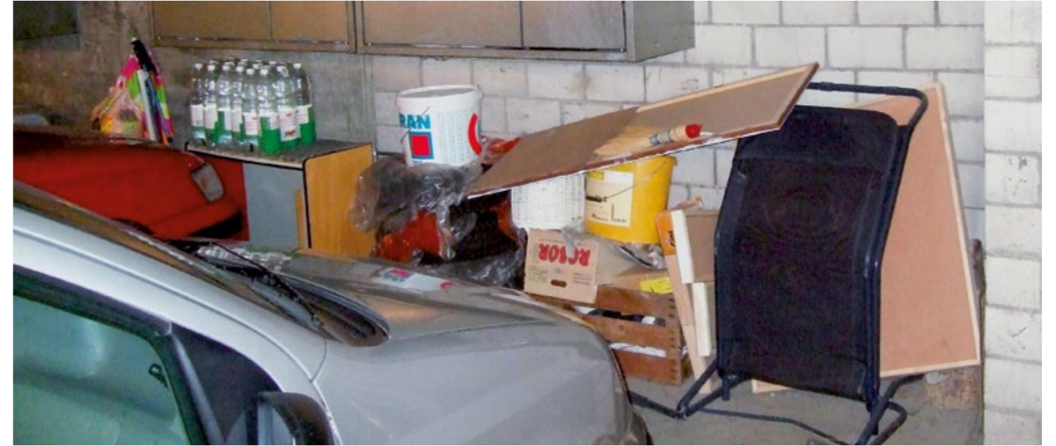
Schlechtes Beispiel einer Einstellhalle: versperrte Fluchtwege, gelagerte Materialien, welche die Brandgefahr erhöhen.
