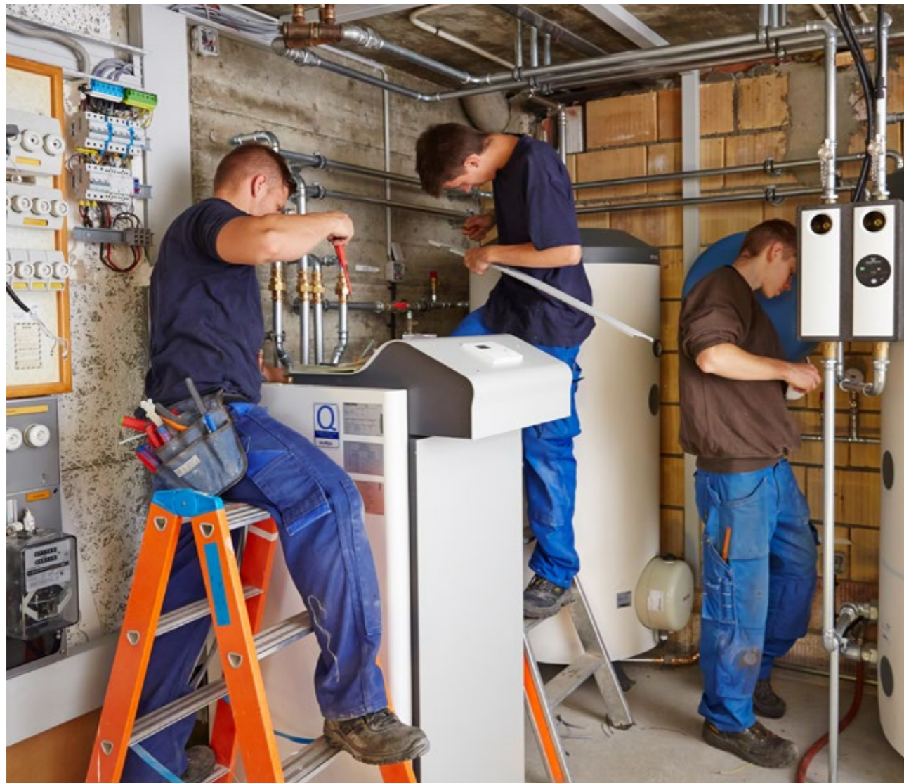
Wärmepumpeninstallateure «in Action».
