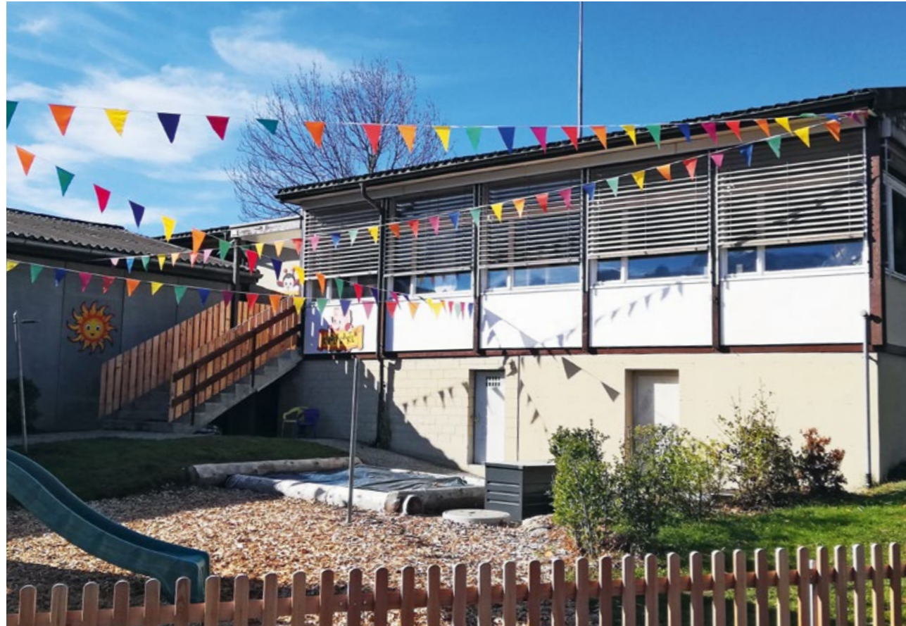
Der Pavillon 3 Hofachern wurde für eine Kindergartenklasse ausgebaut und hergerichtet.
