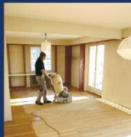
Parkett / Riemenboden schleifen, versiegeln oder ölen.
