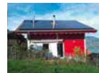
Dies ist eine der 7 Referenzanlagen der EWG, eine Aufdachanlage mit Hochleistungsmodulen in Hondrich
