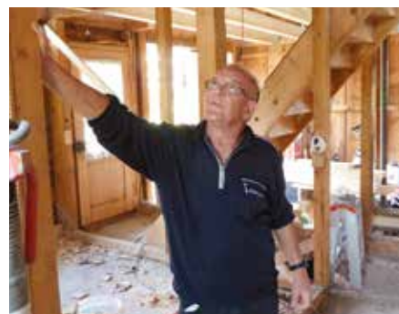
Umfassende Renovationsarbeiten im Zweifamilienhaus der Bürgergemeinde – bald kann das Gebäude wieder vermietet werden.
