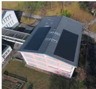
... auf dem Gebäude C (und B) des Schulzentrums Längenstein
