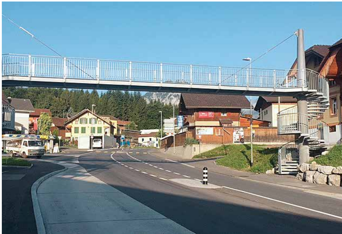
Die erneuerte Passerelle in Spiezwiler ermöglicht, dass die Simmentalstrasse sicher zu Fuss überquert werden kann. Der nahe Fussgängerstreifen – im Hintergrund – wurde ebenfalls saniert und bietet eine zweite sichere Querungsmöglichkeit.
