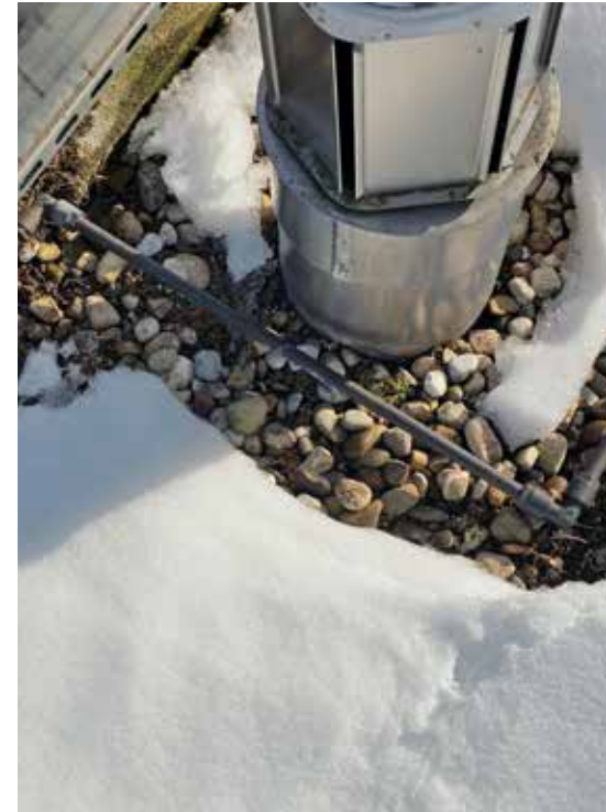
Thermische Solaranlage 25 m 2 . Einsparung durch Weglassen Dämmung CHF 1400.–. Geringere Solarente in 25 Jahren CHF 1900.–
