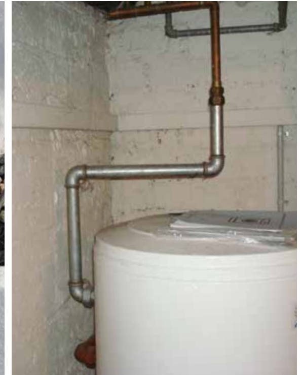
Altbau: Ölkessel mit Boiler. Einsparung durch Weglassen Dämmung CHF 200.–. Mehrverbrauch in 25 Jahren CHF 700.–.
