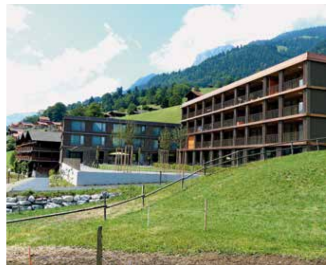
Das Alterszentrum Lindenmatte mit (von links) saniertem Altbau, Erweiterungstrakt und Seniorenwohnungen.
