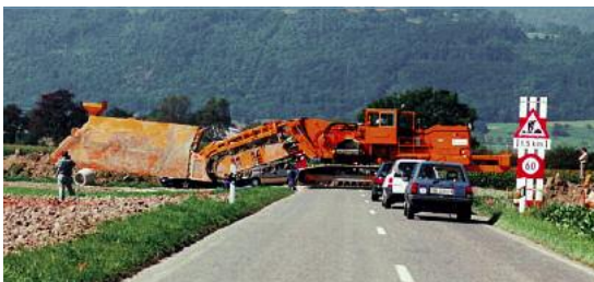
Grossgrabenfräse im Einsatz
