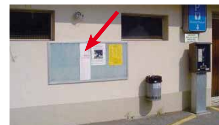
Gebäude Pumpwerk, Parkplatz Dorf (Tenne)
