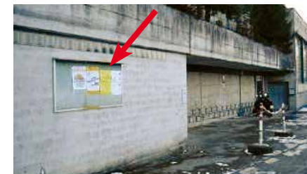
Höhenstrasse, an Mauer beim Schulhaus Roggern
