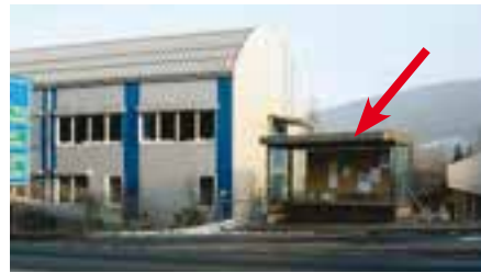
Simmentalstrasse, in Bushaltestelle bei Passarelle
