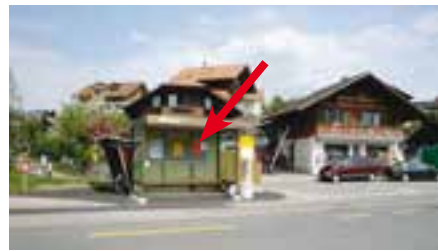
Thunstrasse, in Bushaltestelle, Einmündung Werkstrasse
