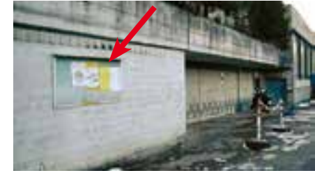
Höhenstrasse, an Mauer beim Schulhaus Roggern
