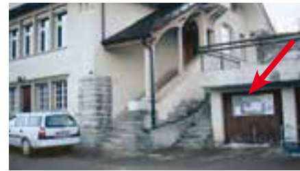
Aeschstrasse, an Garagentor beim Schulhaus
