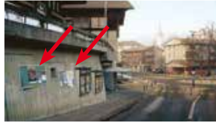
Seestrasse, Kronenplatz, an Stützmauer
