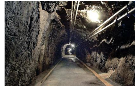
Der Verbindungsgang in der Feuerleitstelle Hondrich.
