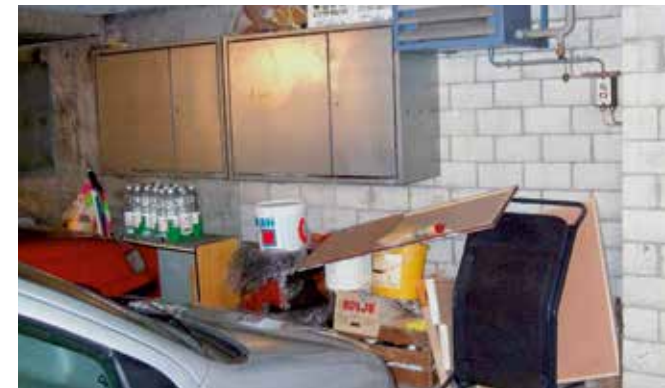
Schlechtes Beispiel einer Einstellhalle: versperrte Fluchtwege, gelagerte Materialien, welche die Brandgefahr erhöhen.
