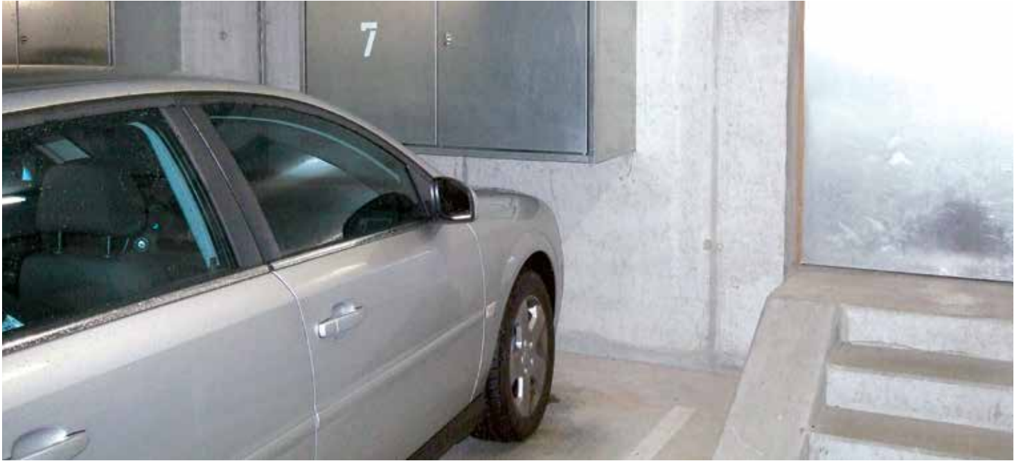
Gutes Beispiel einer Einstellhalle: freie Fluchtwege, keine brandgefährlichen Materiallager.
