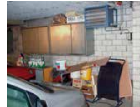
Schlechtes Beispiel einer Einstellhalle
